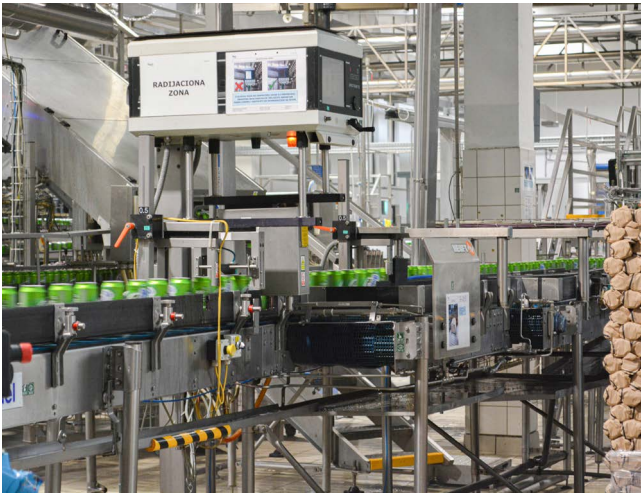
Proceso de trabajo sostenible en línea de llenado de latas.
