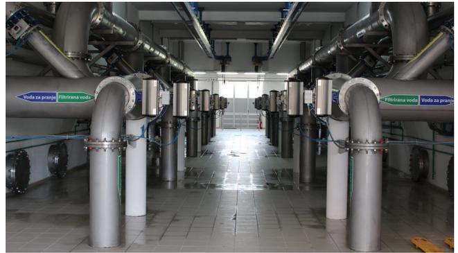
Stabilimento dell'acqua: sistema di filtraggio con sensori.
